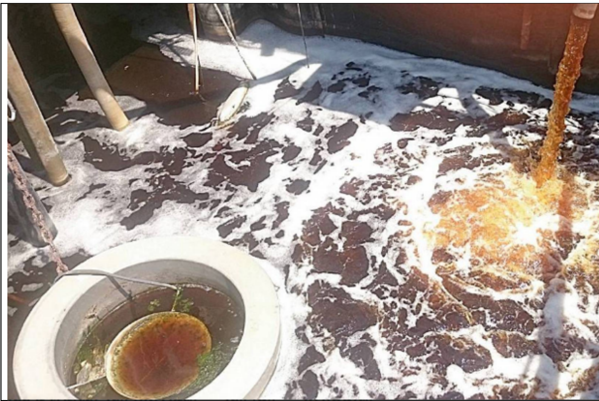
Figure 29: Du lixiviat pompé pour être ensuite traité dans la décharge de Naamé, 2018.
